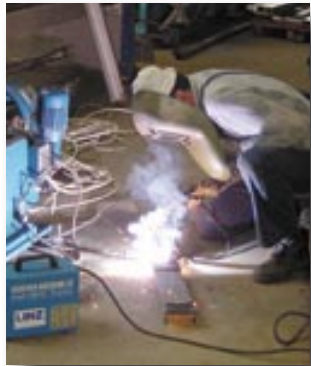
Fertigung einer Sicherheitsabdeckung
